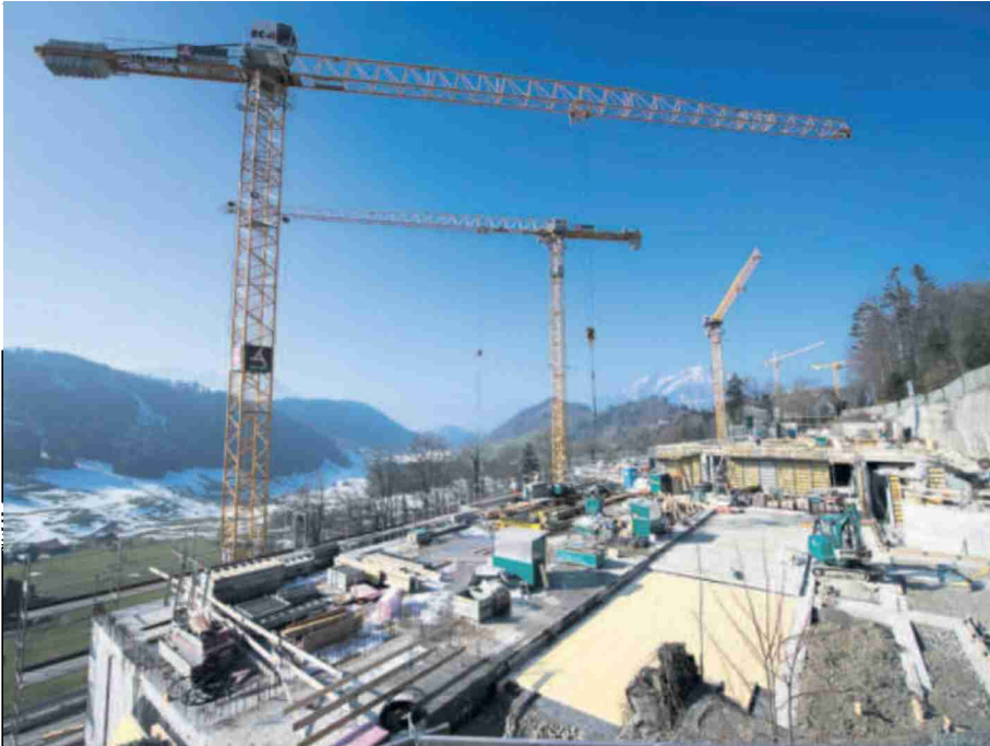
Bis zu 500 Planer und Arbeiter stehen derzeit auf der Grossbaustelle auf dem Bürgerstock im Dauereinsatz. Bild Eveline Beerkircher
