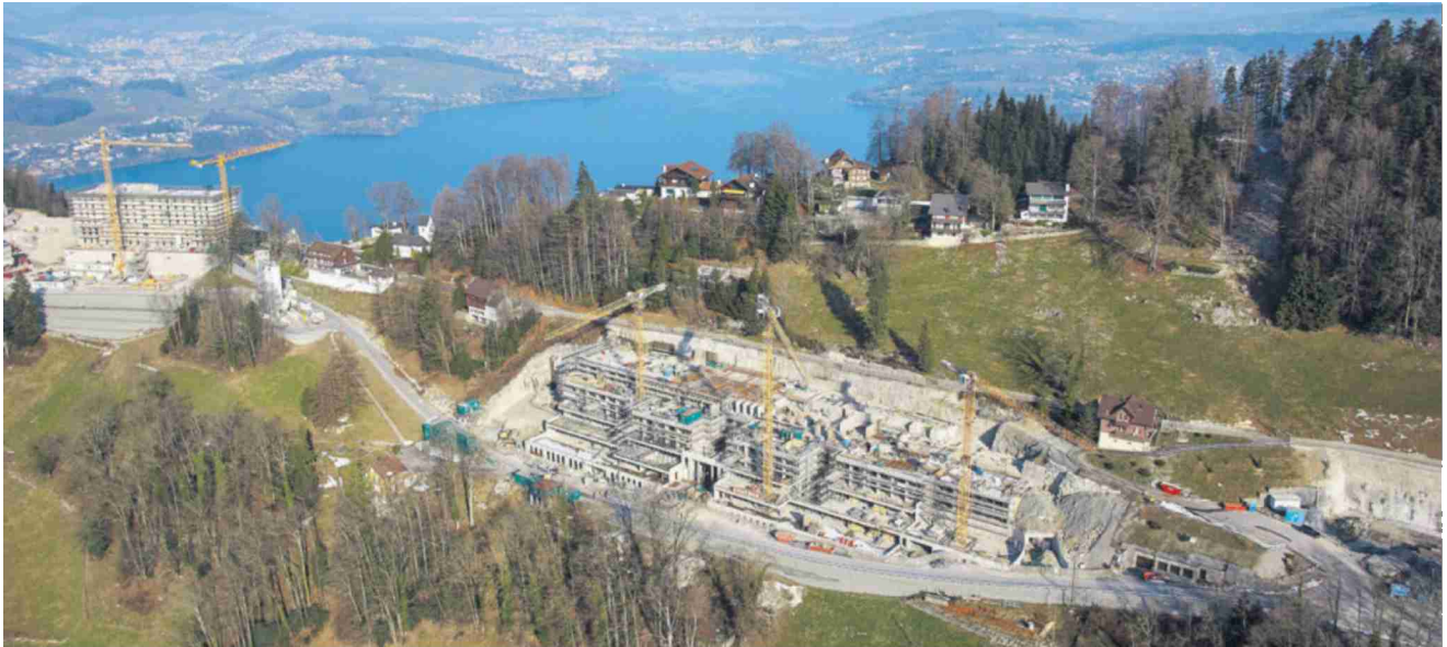
Blick auf die Bürgenstock-Baustellen. Rechts im Vordergrund entsteht das neue Waldhotel, das sich auf Medical-Wellness-Gäste spezialisieren wird.
