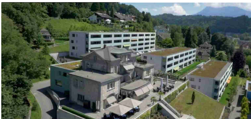
Die Seniorenresidenz Tertianum Bellerive in Luzern – entwickelt und gebaut von der Totalunternehmung Amberg.
