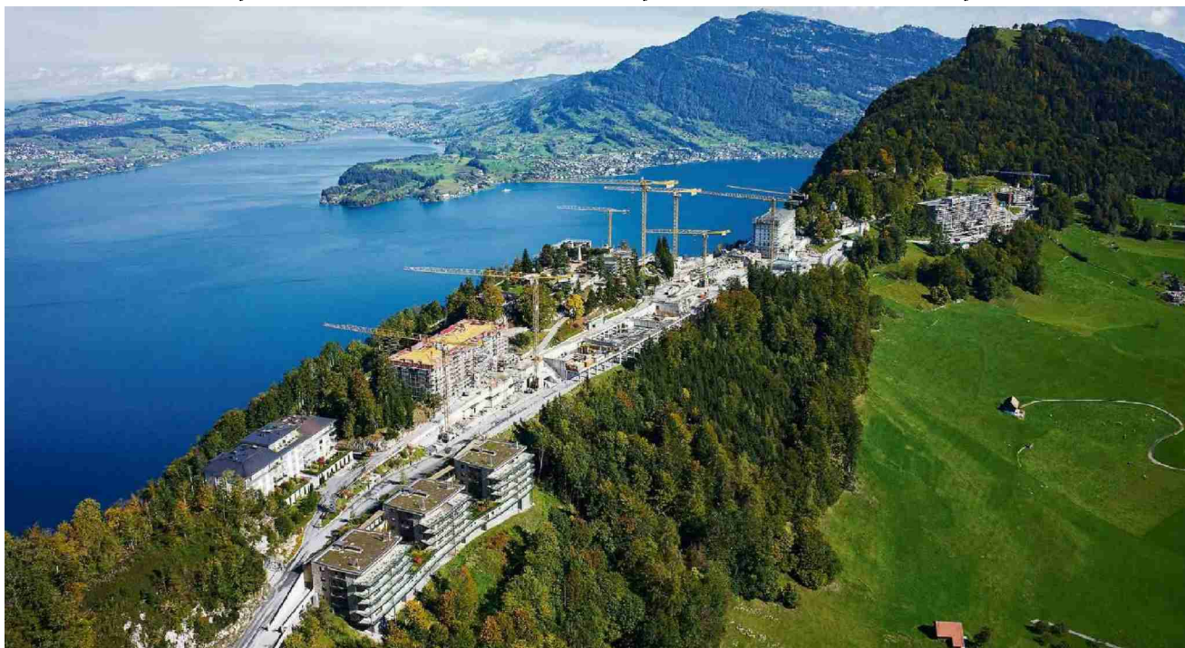
Die Amberg Bauunternehmung ist auf dem Bürgenstock im Rahmen eines Grossprojektes tätig. Sie hat den Zuschlag erhalten für den Bau des Palace Hotel, des Bürgenstock Hotel sowie der Alpine Spa-Anlage. Bilder PD
