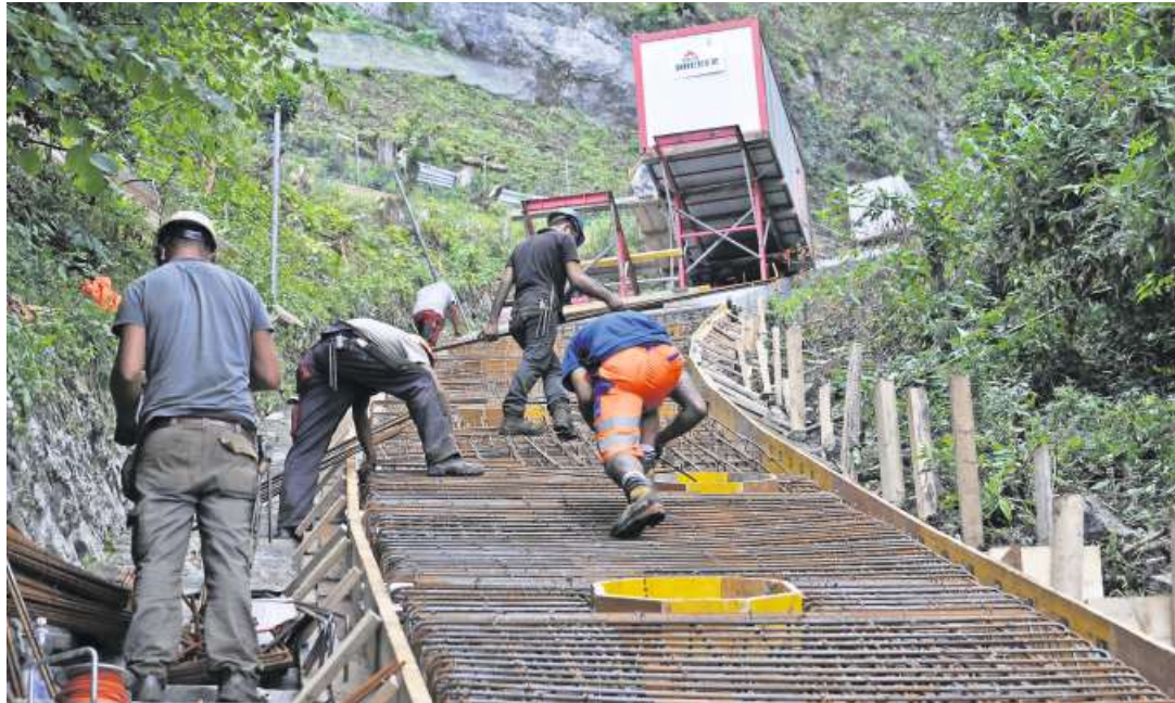
Arbeiter armieren die Ausweichstelle der neuen Bahn.
