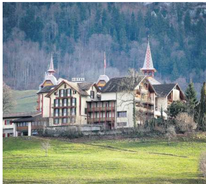
Für das Via-Cordis-Haus wird ein Käufer gesucht. Gleich hinter dem Gebäude steht das «Paxmontana».
